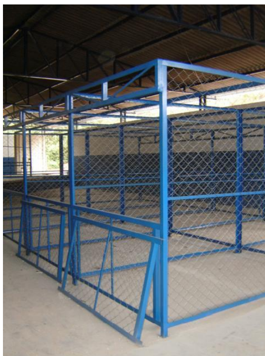
Figura 4: Exemplo de baias em perfis e tela trançada.
