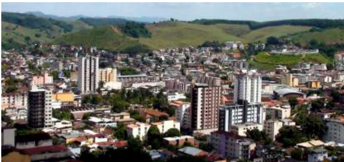
Foto 14: Ponte Nova – MG.
